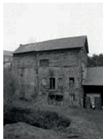
Usine construite vers 1840 par Jacques Deshayes, teinturier ; augmentée en 1881 d'un moulin à indigo, elle se situe à l'entrée du parc de la Carneille.
