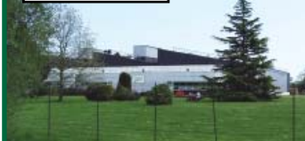
Equipementier Automobile Filtres
