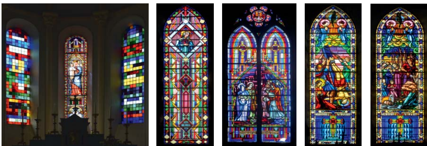
Réparation et entretien des vitraux des églises de La Carneille, Ségrie-Fontaine et Taillebois.
