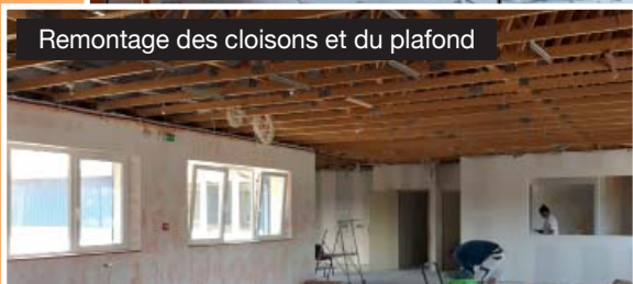
Réfection totale du sol au plafond
