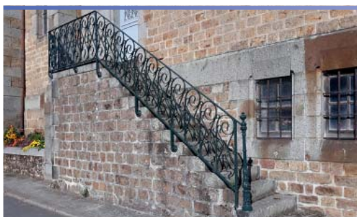
La rampe de l'escalier extérieur de l'église d'Athis après restauration.
