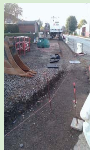
Les travaux de la rue Maurice-Duron à Athis
