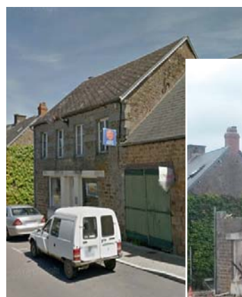
L'ancien bar de Ségrie a été démoli : cette réserve foncière permet d'anticiper d'éventuels projets conforme à la préservation de nos commerces en milieu rural.
