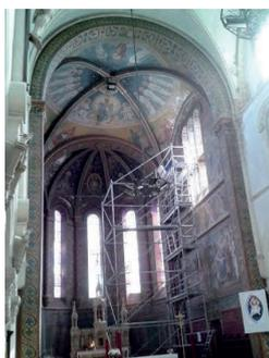
L'échafaudage mis en place pour le démontage puis le remontage du vitrail afin de ne pas abîmer les peintures classées.
