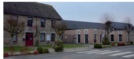
École primaire de Ségrie-Fontaine
